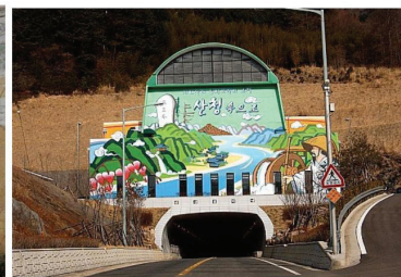
터널 전면부 옹벽
