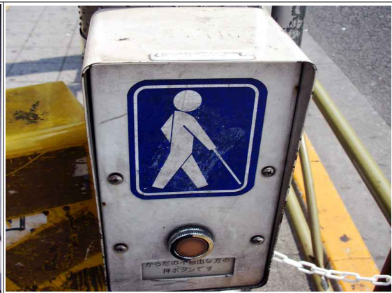
횡단보도 부근 설치된 음향신호기
