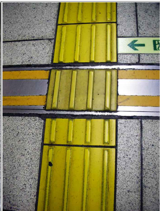
차수막 위에 점자블록을 설치한 사례
