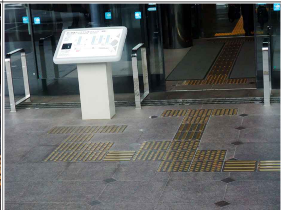
점자안내판 부근 황동재질의 점자블록 설치
