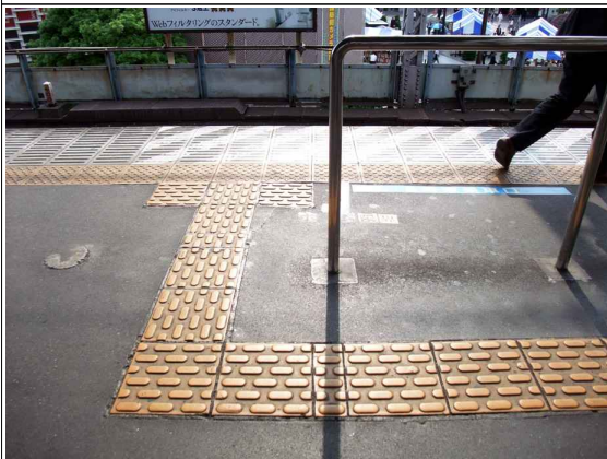
승강장 부근 선형과 점형이 혼용된 설치
